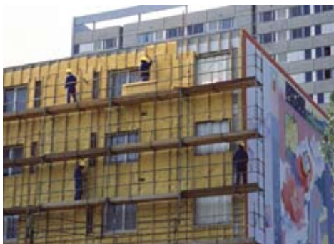
Isolation d'une façade d'immeuble par l'extérieur.
